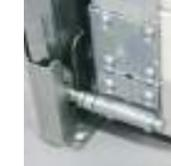
Les points de fixation au sol limitent le déraillement des galets bas en cas de tentatives d'effractions.
