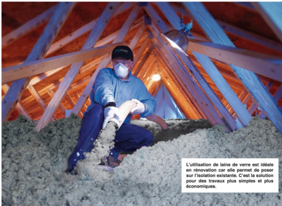
L'utilisation de laine de verre est idéale en rénovation car elle permet de poser sur l'isolation existante. C'est la solution pour des travaux plus simples et plus économiques.
